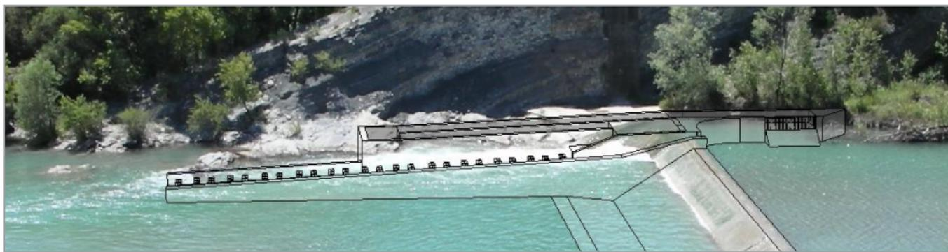
La passe à poissons de Peipin, conçue pour favoriser le développement de l'Apron, espèce endémique et très protégée, est construite au niveau du barrage de Salignac. Cependant, l'ouvrage n'a pas encore été officiellement livré à son promoteur, EDF, car il a subi quelques dégradations à la suite de la crue de la Durance cette année.
