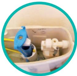
Enfin, en attendant de s'équiper, un simple réglage du flotteur vers le bas (en modifiant la courbure de la tige ou par un réglage simple) permet de diminuer de manière significative le volume d'eau chassé à chaque utilisation.
